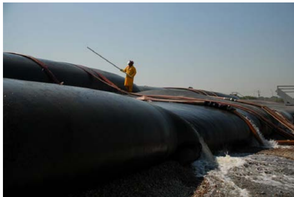
Figura 21. Geotêxtil contendo materiais dragados do Canal do Fundão. Fonte: Programa de Revitalização do Canal do Fundão, 2016
